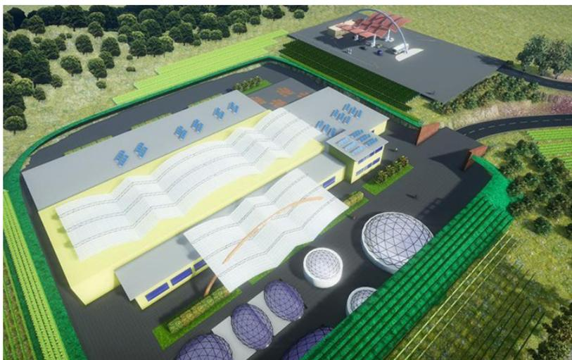
Si tratta di un mega-impianto, lungo 300 m cioè come 3 campi da calcio in cui i fanghi rimarranno 40 gg a subire una putrefazione anaerobica. Si formerà gas metano che dovrebbe essere usato nell'inceneritore. Il metano è un gas serra con effetti superiori alla CO<sub>2</sub>. Su 4 turbine solo una sarà alimentata da questo gas, per il resto sarà utilizzato metano dalla rete.
