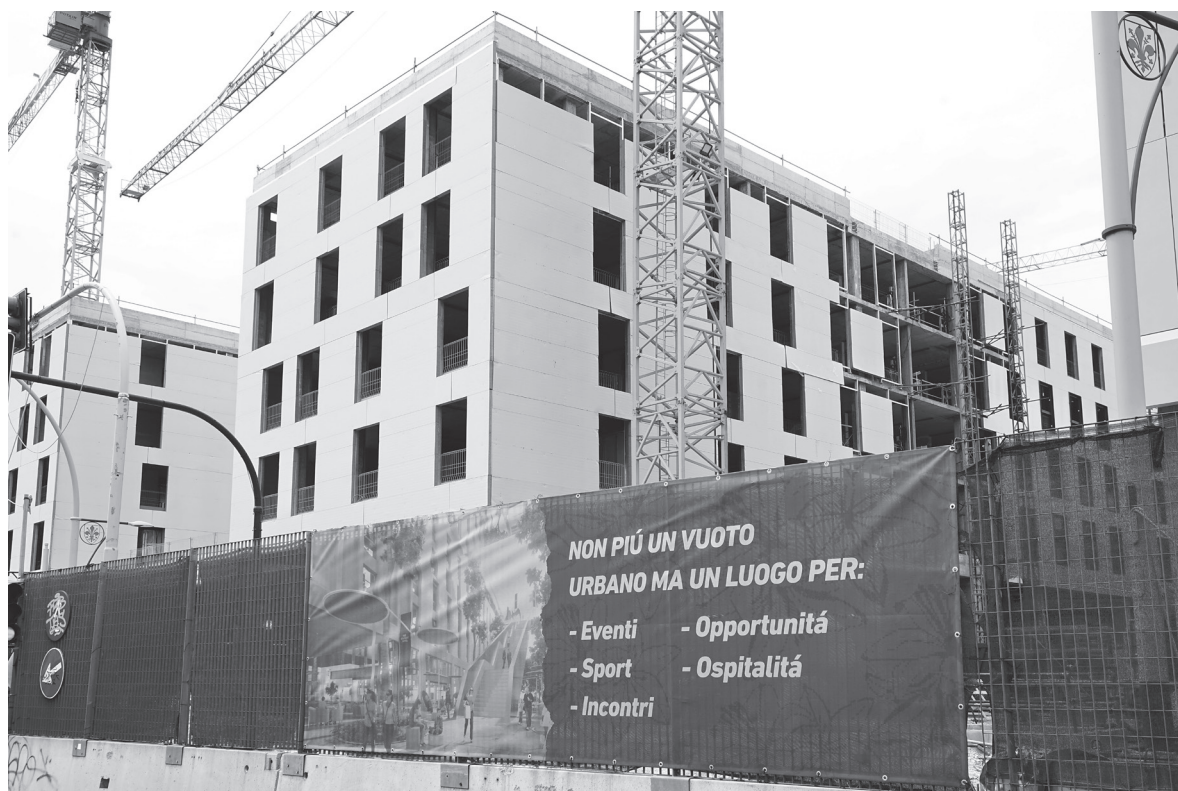
Un nuovo student hotel in costruzione sul viale Belfiore a Firenze. Fotografia: Stefano Sansavini.
